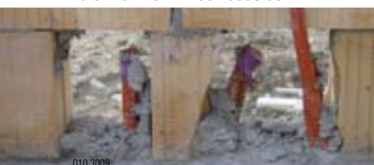
Mittels Sternverkabelung werden Datenleerrohre in jedes Zimmer geführt.
