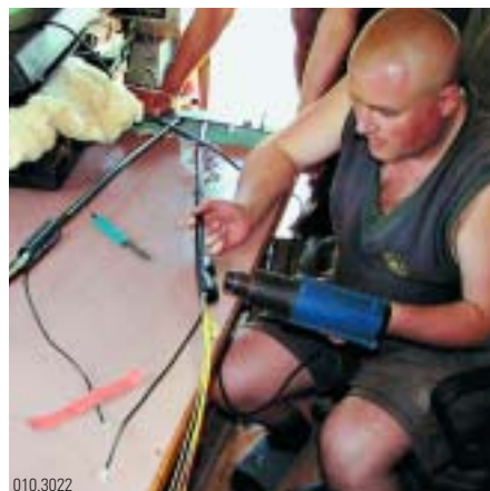
Splessarbeiten vor Ort
